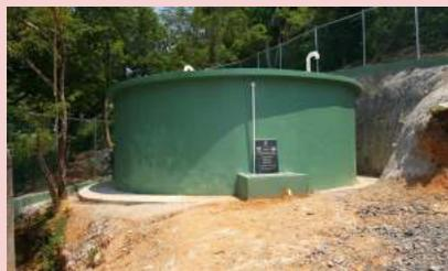
Con el propósito de aumentar el suministro de agua en la comunidad de Lucy Point se está llevando a cabo la construcción de un tanque de almacenamiento de 28,000 galones de agua potable y se están ampliando las líneas de distribución para que más personas tengan acceso a este vital líquido.
